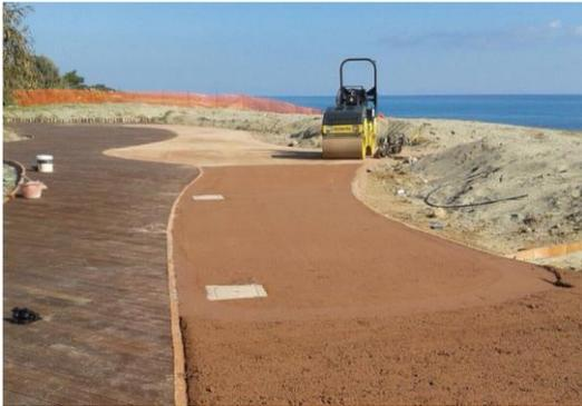
I percorsi sono stati pensati sul concetto della stabilizzazione naturale, che prevede l'aggiunta di particolari materiali a uno stabilizzato di cava/riciclato, al fine di migliorare le qualità geo-meccaniche della miscela (coesione, angolo d'attrito interno, portanza, resistenza all'acqua e al gelo, ...) e di stabilizzare le caratteristiche della miscela al variare del tempo, delle condizioni ambientali, dell'umidità, ecc.
